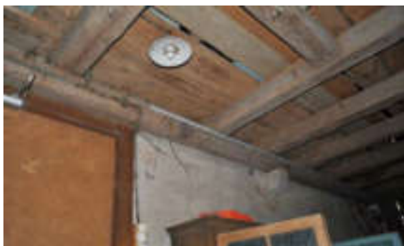
Abb. 117: Futtertenn, Scheidewand mit Auflager für Balken.
