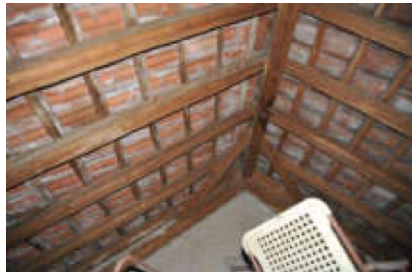
Abb. 29: 2. Dachgeschoss, liegender Stuhl in Q7.
