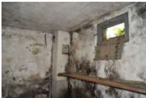
Abb. 174: Waschhaus (?), Inneres, Blick nach Nordwesten mit Kaminschacht.
