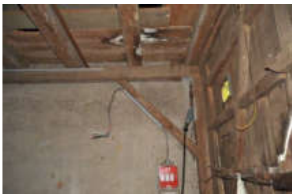
Abb. 119: Futtertenn, Blick nach Osten an die Scheidewand, rechts das zweiflüglige Tor.
