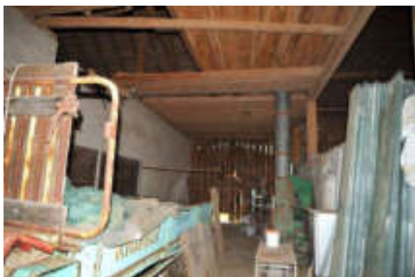
Abb. 123: Tenn, Blick nach Norden. Rechts die gemauerte Stallwand.
