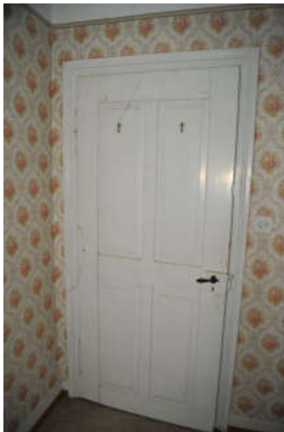
Abb. 56: Standardtür: Vierfüllungstür mit mehrfach profilierten Türeinfassungen. Die Füllungsaufteilung ist charakteristisch um 1800-1830, tritt jedoch auch noch in der 2. Hälfte des 19. Jahrhunderts auf.
