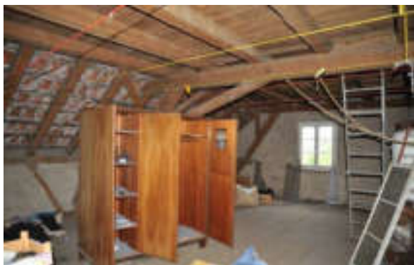
Abb. 109: 1. Dachgeschoss über dem Wohnteil, Blick nach Nordosten.
