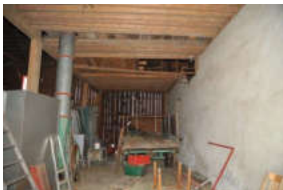
Abb. 124: Tenn, Blick nach Süden. Rechts die ehemalige östliche Giebelfassade, heute die Trennung zur westlichsten Querzone mit Remise.
