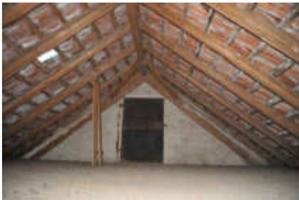
Abb. 28: 2. Dachgeschoss, liegender Stuhl in Q5.
