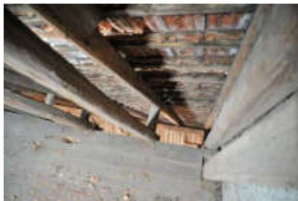
Abb. 36: Ökonomie, 2. Dachgeschoss, Dachüberstand bzw. Anhebung nach Norden.
