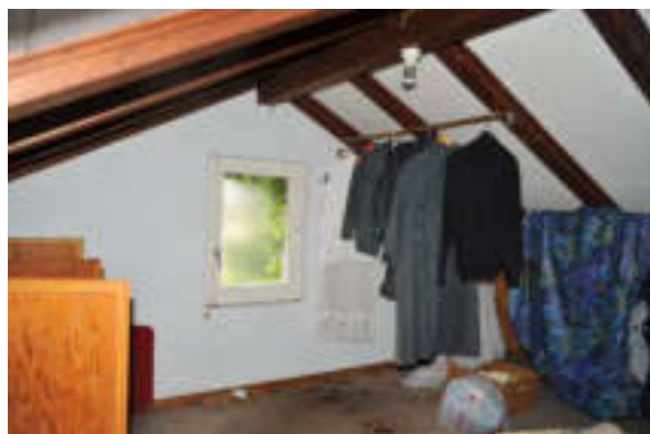
Abb. 165: Dachzimmer über dem östlichen Gebäudeteil, Blick nach Südosten.
