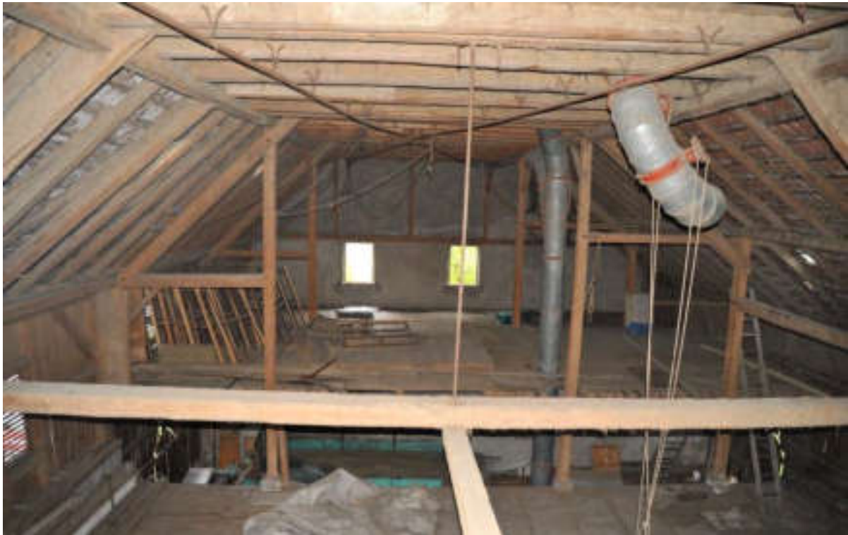
Abb. 30: Blick von der Scheidewand in die Ökonomie mit Dachwerk aus unterschiedlichen Bauphasen. Die beiden westlichsten Querzonen mit kombiniertem Stuhlgerüst aus stehenden und als Zange liegenden Stühlen sind jünger, als die östlichen Querzonen.
