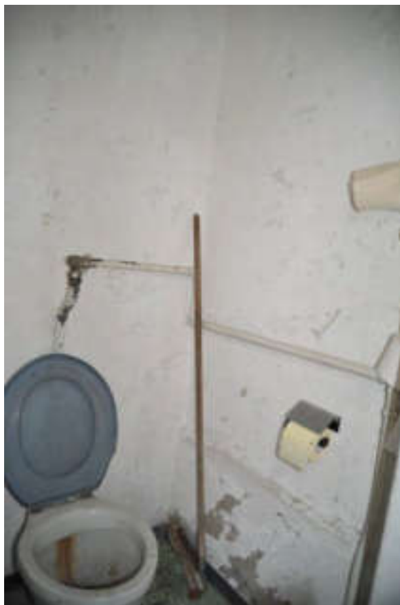
Abb. 92: WC 008, Blick nach Südosten.
