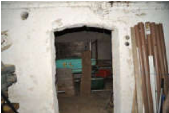
Abb. 121: Blick vom Stall in das Tenn nach Westen, der Durchgang verfügt über einen segmentbogenförmigen Sturz.
