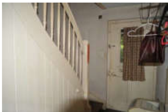
Abb. 141: Östlicher Gebäudeteil, Erdgeschoss, Korridor, Blick nach Norden. Treppe mit gedrechselten Staketen (001).
