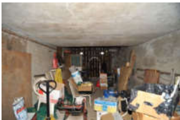
Abb. 115: Futtertenn mit Hourdisdecke nach Norden. Blick nach Süden.
