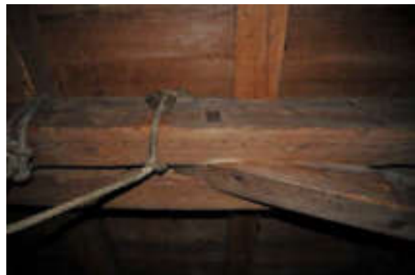
Abb. 27: 1. Dachgeschoss, Kehlbalkenzange in Q6.
