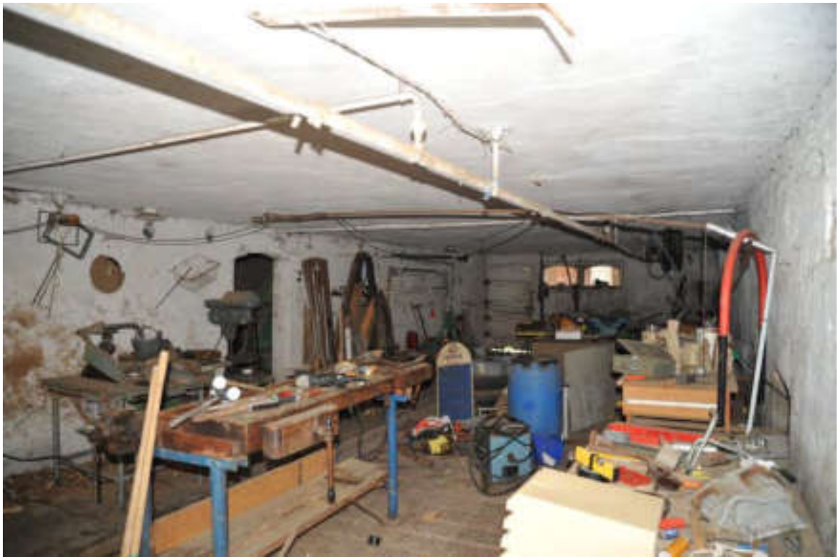
Abb. 120: Stall mit Hourdisdecke und Tonplattenboden, die gemauerten Wände sind verputzt. Blick nach Norden.
