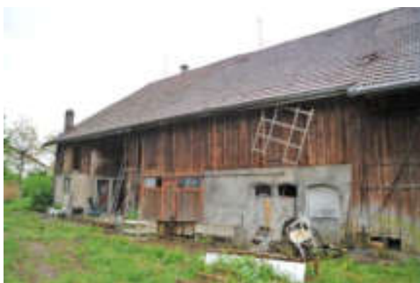
Abb. 49: Nördliche Trauffassade, Wohnhaus mit Stall und Futtertenn (ehemaliges Tenn) des ursprünglichen Kernbaus von 1823.
