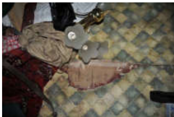
Abb. 90: Kammer 006, Bretterboden unter dem Novilon-/PVC-Belag.
