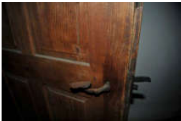
Abb. 61: Türdrücker der Hauseingangstür nach Norden.
