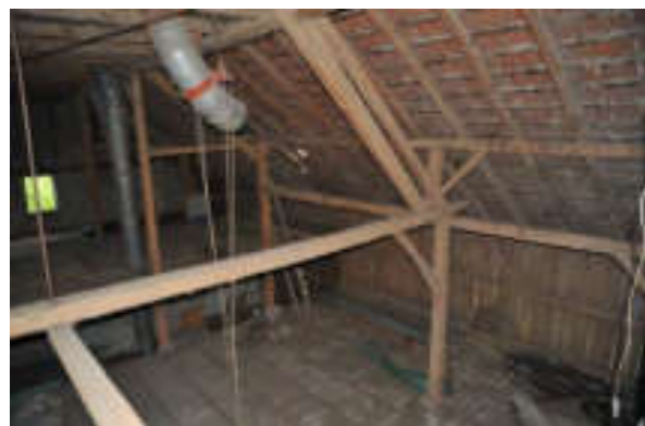
Abb. 34: Ökonomie, 1. Dachgeschoss, Querbund 4 mit liegendem Stuhlgerüst, wohl 1823. Im Hintergrund Q3 mit stehendem Stuhl und liegender Zange.
