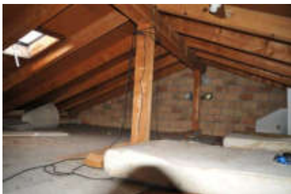
Abb. 164: Dachgeschoss über dem westlichen Gebäudeteil, Blick nach Südwesten.
