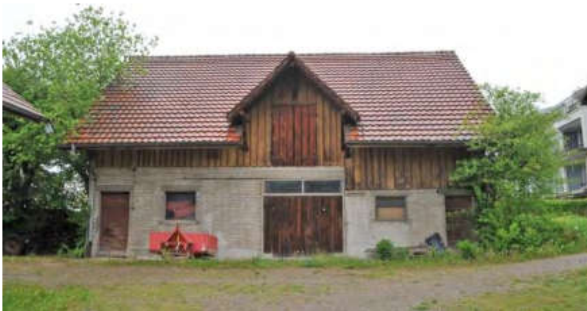
Abb. 166: Scheune, Blick an die östliche Trauffassade mit Stalleinbauten und Quergiebel.
