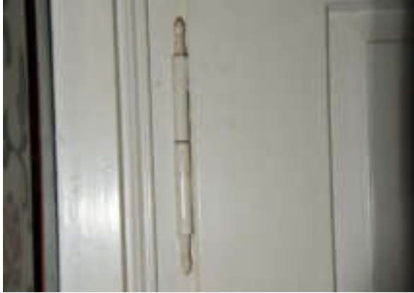
Abb. 57: Fischband mit tropfenförmigen Zierknöpfen, typologisch charakteristisch ab der 2. Hälfte des Jahrhundert und daher der Bauphase von 1880 zuzuordnen.
