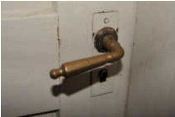
Abb. 59: Konischer Türdrücker der Standardtüren im EG mit kugelförmigen Zierknöpfen in Historismus-Form (1880).
