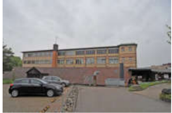
Abb. 14: Pfeil 4, Blick nach Süden auf die Schuhfabrik Walder.
