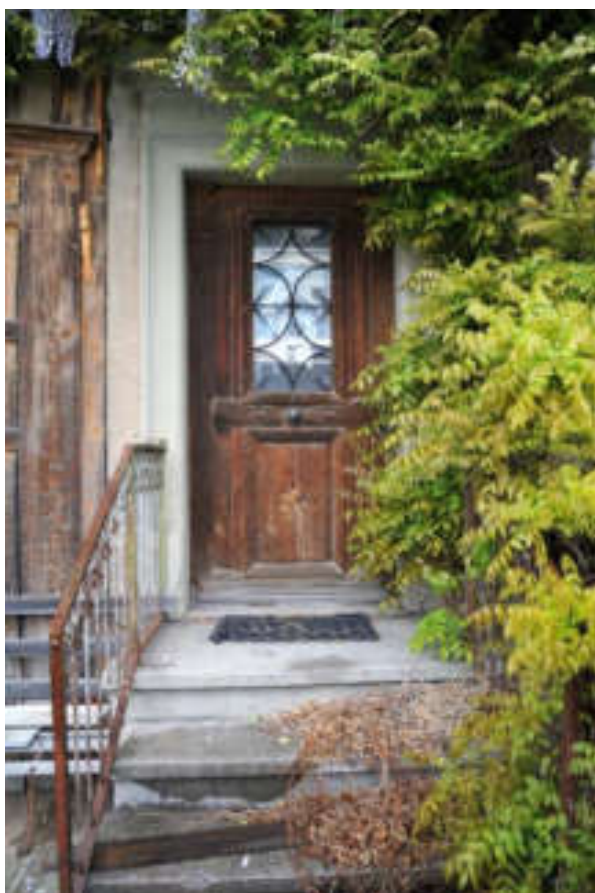
Abb. 42: Südliche Trauffassade, Hauseingangtür mit eingelegtem Stern im unteren Feld sowie schmiedeeisernem Gitter im oberen Feld sowie Kunststeintreppe mit Eisengeländer.
