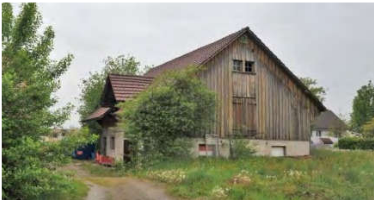
Abb. 167: Scheune, Blick an die nördliche Giebelfassade.
