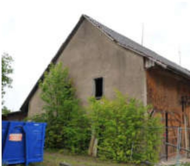
Abb. 54: Verputzte, westliche Giebelfassade von 1906.
