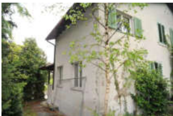
Abb. 131: Wohnhaus, Ansicht der nördlichen Trauffassade.
