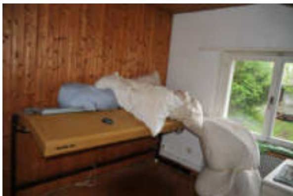
Abb. 158: Westlicher Gebäudeteil, Obergeschoss, Zimmer, Blick nach Südwesten (107).
