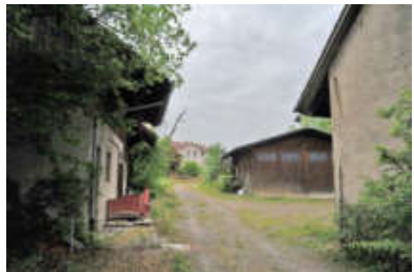
Abb. 18: Pfeil 8, Blick von der Riedmühlestrasse in die Hofsituation nach Nordosten. Rechts das Vielzweckbauernhaus, links die Scheune und in der Mitte der Schopf.
