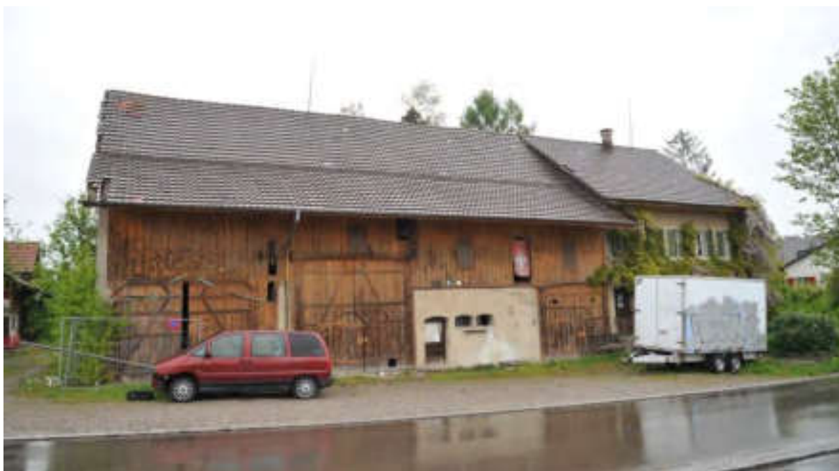
Abb. 37: Südliche Trauffassade mit Nutzungsaufteilung in Wohnhaus und vierzonige Ökonomie.
