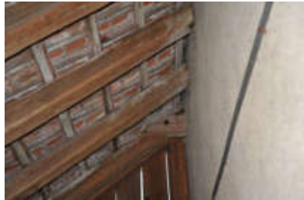
Abb. 25: Aussteifende Zange der Traufwand in Q7.
