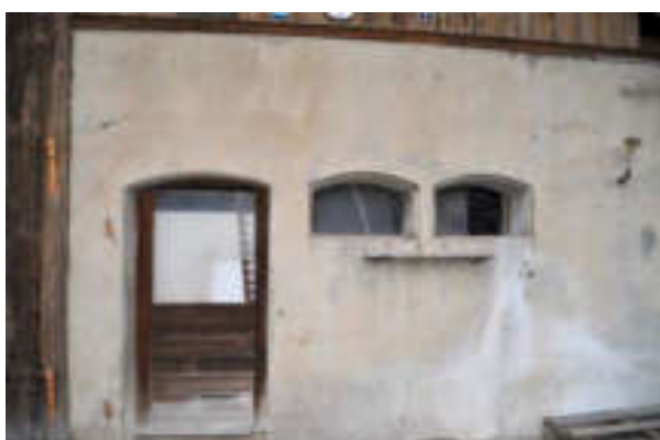
Abb. 46: Südliche Trauffassade, verputzter Stalleinbau mit segmentbogenförmigen Öffnungen.
