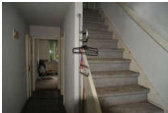
Abb. 150: Westlicher Gebäudeteil, Erdgeschoss, Korridor, Blick nach Süden (006).
