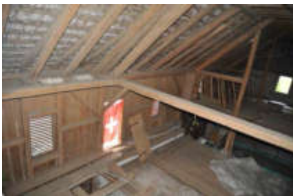
Abb. 33: Ökonomie, 1. Dachgeschoss, Querbund 4 mit liegendem Stuhlgerüst und Dachfusskonstruktion mit Stich- und Wechselbalken, wohl 1823. Im Hintergrund Q3 mit stehendem Stuhl und liegender Zange.
