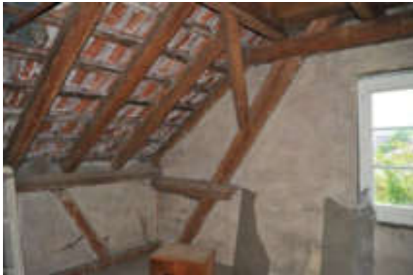
Abb. 24: 1. Dachgeschoss, liegender Stuhl in der östlichen Giebelwand (Q7) mit Zange über der Trauf- bzw. Kniewand.
