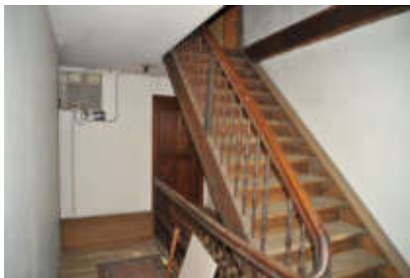
Abb. 95: Korridor 101 mit Vertikalerschliessung, Blick nach Süden.
