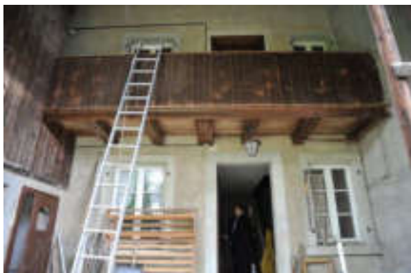
Abb. 51: Nördliche Trauffassade, Wohnteil mit Abtrittanbau und Laube.
