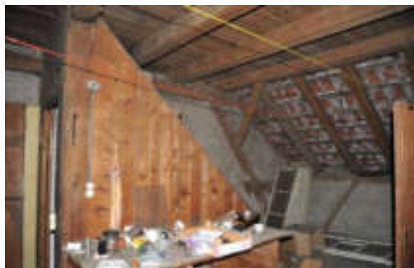
Abb. 110: 1. Dachgeschoss über dem Wohnteil, Blick nach Nordwesten.
