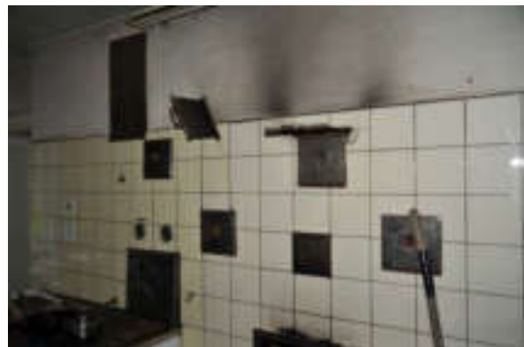
Abb. 86: Küche 004, Feuerwand mit Ofeneinfeuerung für den Kachelofen.
