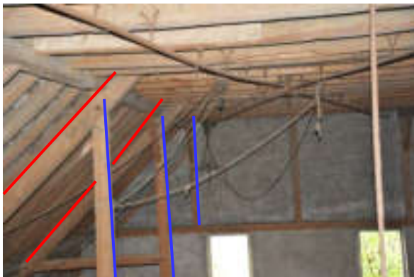
Abb. 31: Ökonomie, 1. Dachgeschoss. Q1-Q3 mit doppelt stehenden Stühlen (blau) und liegender Zange (rot).
