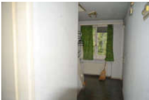
Abb. 149: Westlicher Gebäudeteil, Erdgeschoss, Korridor, Blick nach Norden (006).
