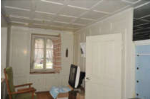
Abb. 79: Nebenstube 003, Blick nach Südwesten.
