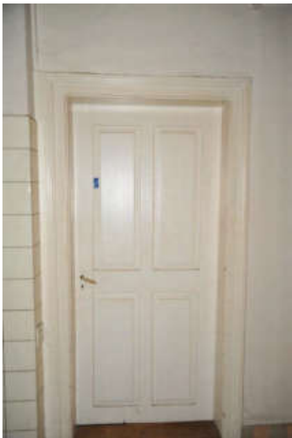
Abb. 55: Standardtür: Vierfüllungstür mit mehrfach profilierten Türeinfassungen. Die Füllungsaufteilung ist charakteristisch um 1800-1830, tritt jedoch auch noch in der 2. Hälfte des 19. Jahrhunderts auf.
