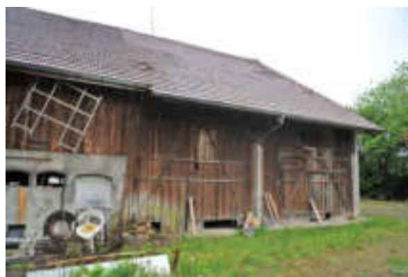
Abb. 50: Nördliche Trauffassade, Tenn (1880) und Remise (1906), beide als sekundäre Erweiterungen des Kernbaus von 1823.
