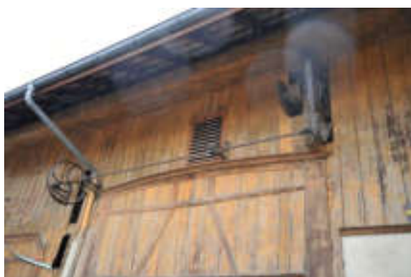
Abb. 47: Südliche Trauffassade, unverkleidete Dachuntersicht und Tenntor mit Heuaufzug.
