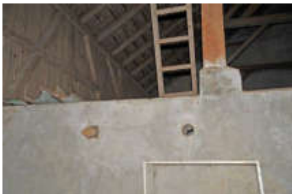
Abb. 125: Tenn, Blick nach Osten an die Stallwand.
