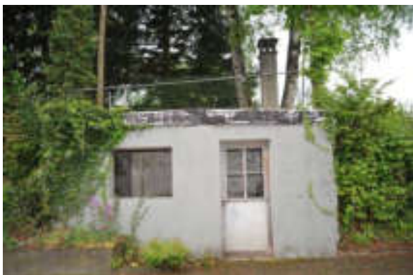
Abb. 173: Waschhaus (?), Blick nach Westen.
