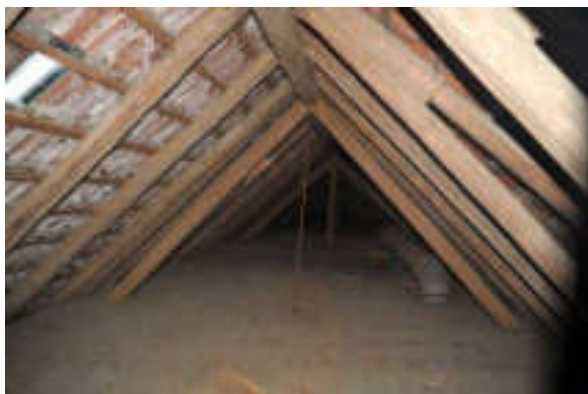
Abb. 35: Ökonomie, 2. Dachgeschoss mit durchlaufenden Stuhlstreben und Firstsäulen in Q2 und Q3.
