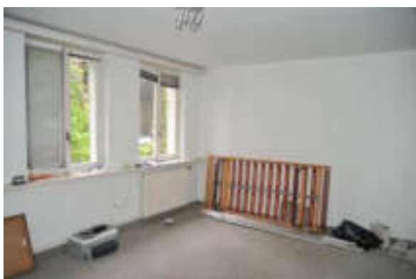
Abb. 153: Westlicher Gebäudeteil, Erdgeschoss, Wohnzimmer, Blick nach Südwesten (009).
