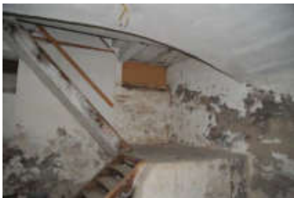
Abb. 66: Gewölbter Keller -101 mit Treppe, Blick nach Westen.
