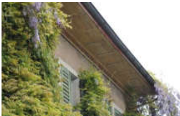
Abb. 40: Südliche Trauffassade, vertäfelte Dachuntersicht des Wohnteils mit Zahnschnittfries.
