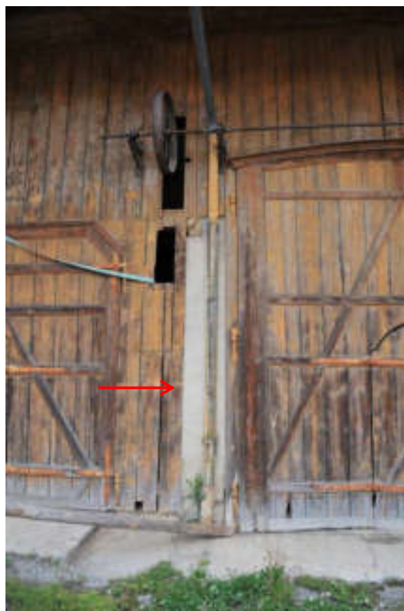
Abb. 43: Südliche Trauffassade, Ökonomie mit Tenn- und Remisentor sowie Heuaufzug. Zwischen den beiden Querzonen die ehemalige westliche Giebelfassade.
