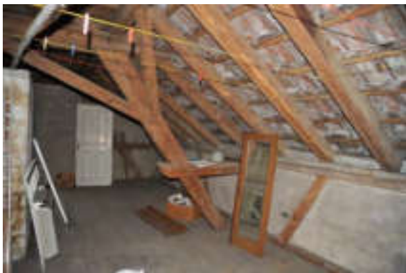
Abb. 26: 1. Dachgeschoss, liegende Stühle in Q6 und Q5.
