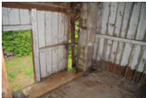
Abb. 107: Abtrittbau mit Kamin über dem Waschhaus, Blick nach Nordosten.
