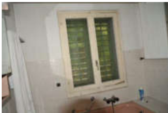
Abb. 144: Östlicher Gebäudeteil, Erdgeschoss, Bad, Blick nach Nordosten (002).
