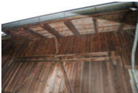
Abb. 52: Nördliche Trauffassade, Ökonomie im Bereich des Trens, Dachuntersicht und Versatz in der Dachfläche (1906).
