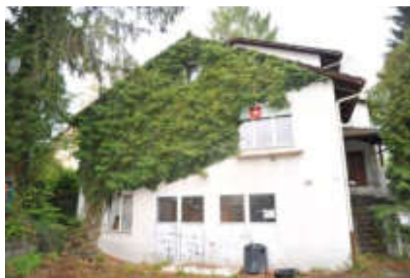
Abb. 132: Wohnhaus, Ansicht der östlichen Giebelfassade.
