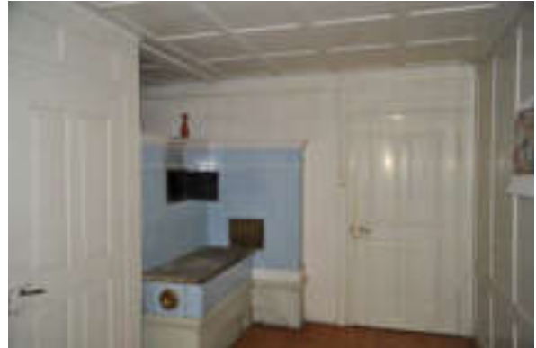
Abb. 80: Nebenstube, Blick nach Norden. Über dem Kachelofen sind Nebenstube 003 und Stube 002 verbunden / offen.
