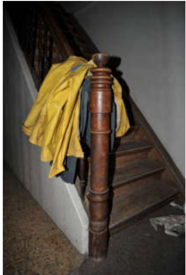
Abb. 72: Treppe mit gedrehten Staketen und Antrittspfosten (1880).
