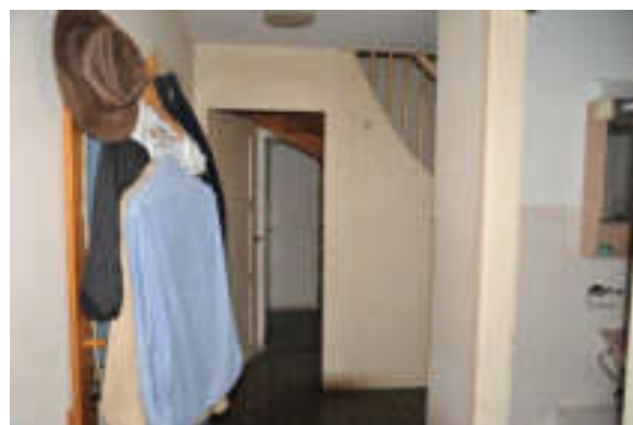
Abb. 142: Östlicher Gebäudeteil, Erdgeschoss, Korridor, Blick nach Westen. (001).
