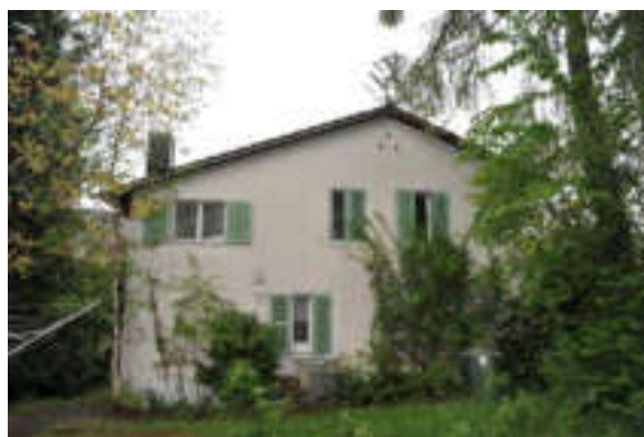
Abb. 130: Wohnhaus, Ansicht der westlichen Giebelfassade
