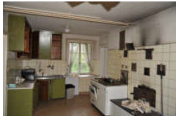
Abb. 84: Küche 004, Blick nach Südosten.
