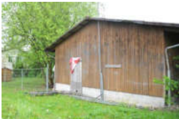
Abb. 169: Geräteschuppen, Blick an die nördliche Giebelfassade.
