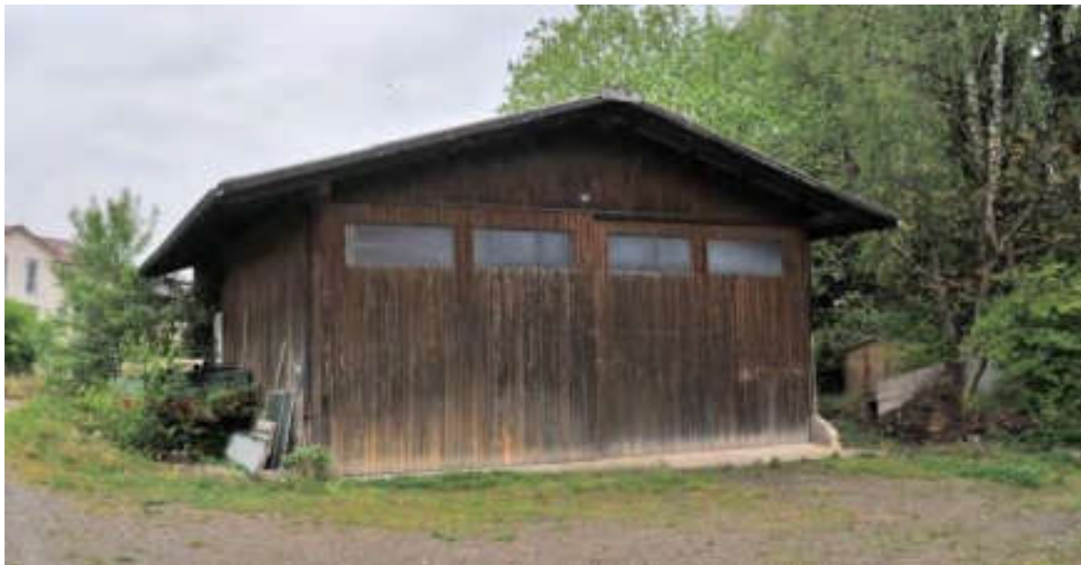
Abb. 168: Geräteschuppen, Blick an die südliche Giebelfassade mit grossem Schiebetor.
