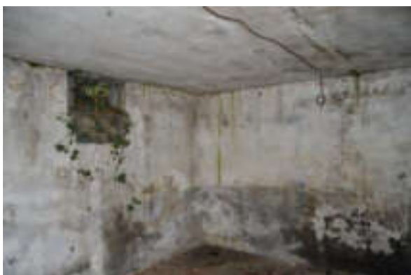
Abb. 175: Waschhaus (?), Inneres, Blick nach Südwesten.
